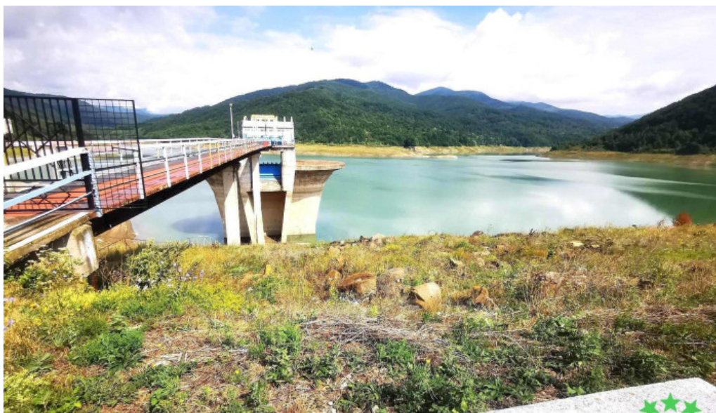
Barajul maneciu pod
