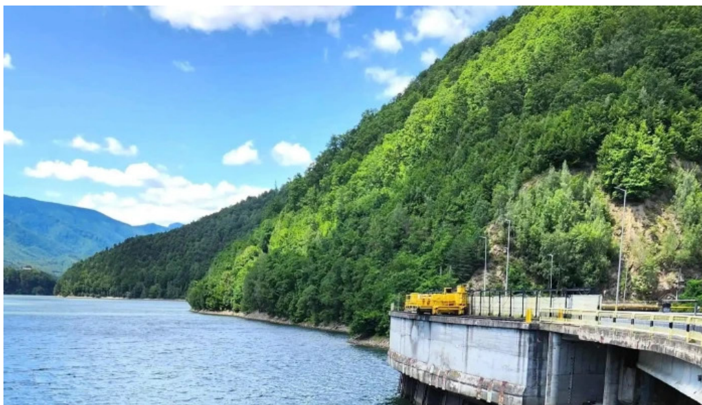
Barajul malaia aproape de mine
