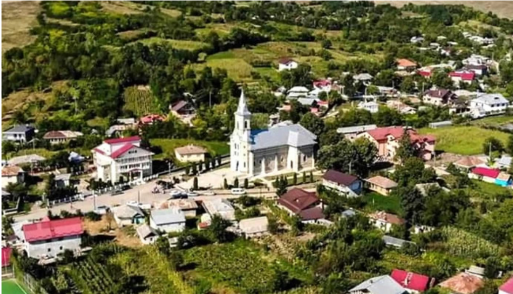
Biserica romano catolica sf iosif muncitorul aproape de mine
