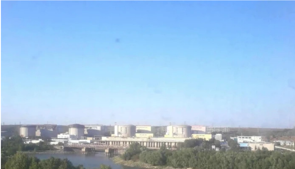
Centrala nucleara de la cernavoda num?r
