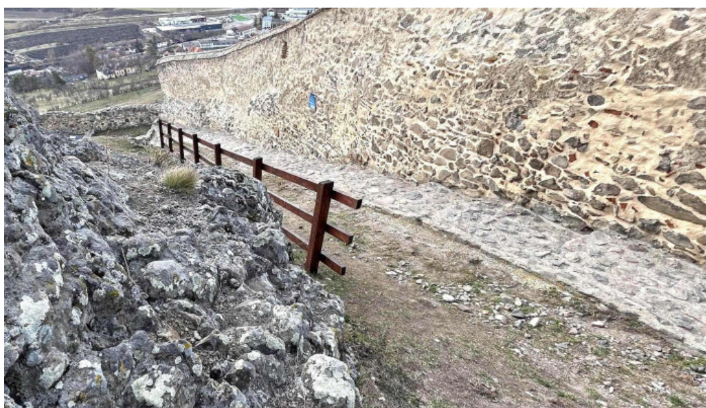
Turnul slaninii aproape de mine
