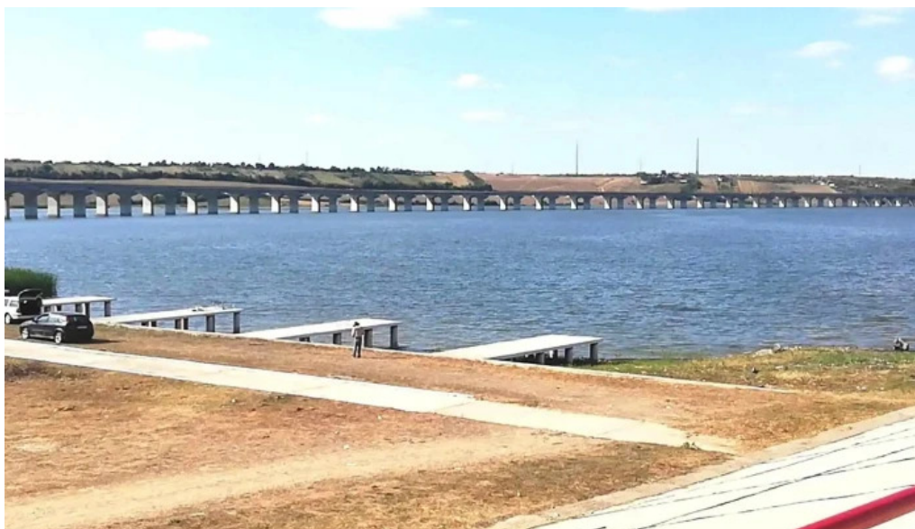
Barajul de acumulare suplacu de barcau aproape de mine
