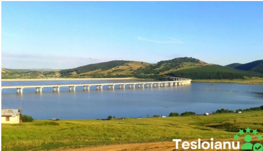
Barajul de acumulare suplacu de barcau munte
