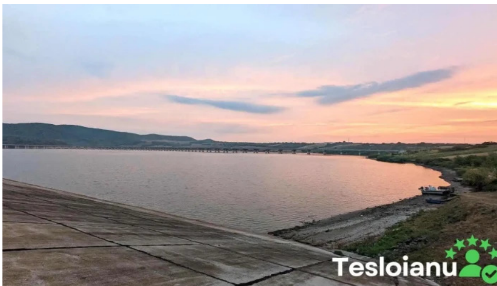
Barajul de acumulare suplacu de barcu?u romania
