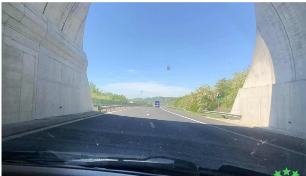
Branisca aproape de mine
