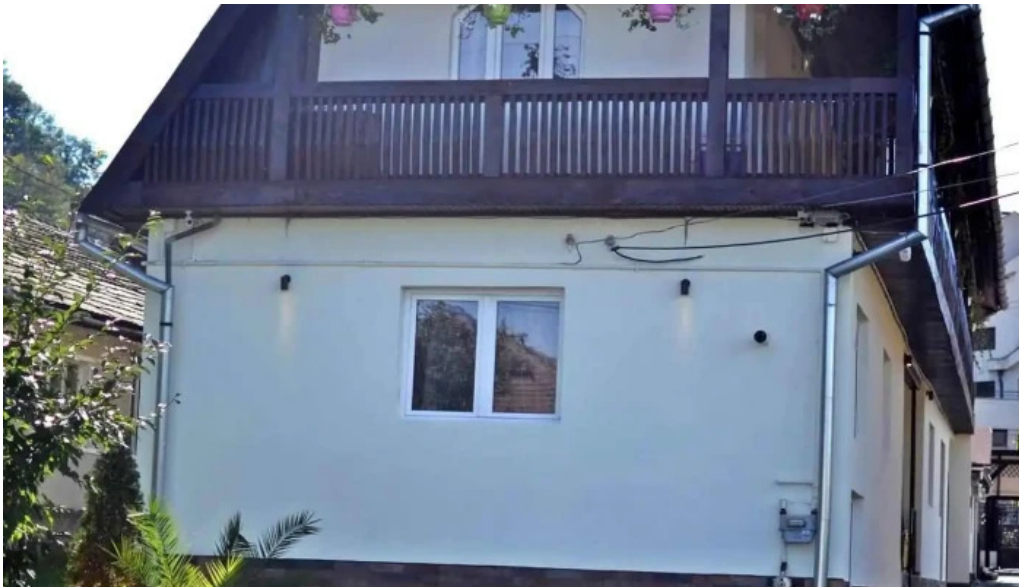
Casa sasului exterior
