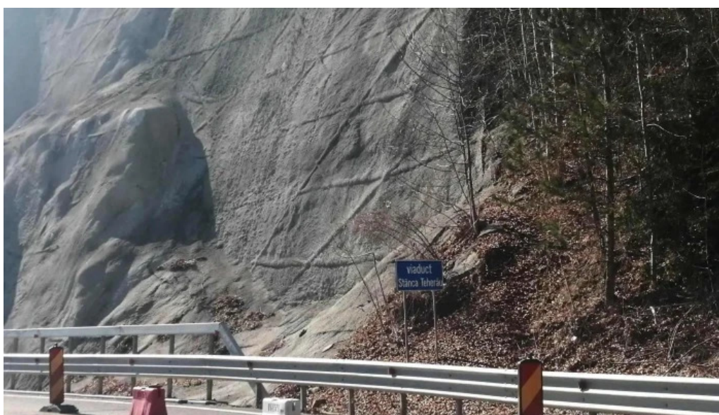
Viaductul stanca teherau reduceri
