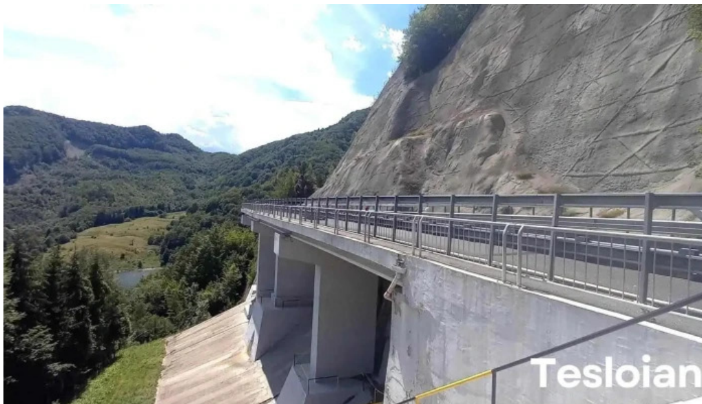
Viaductul stanca teherau pod
