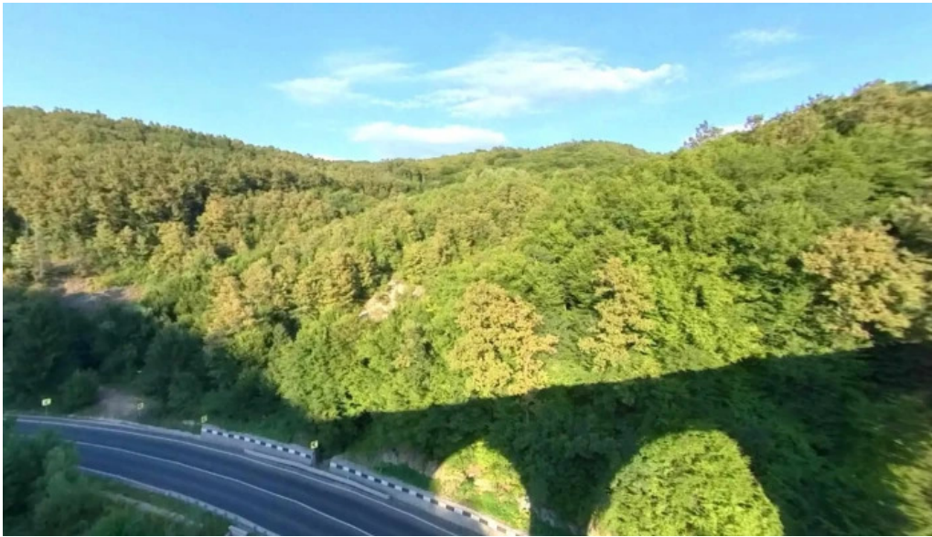
Viaductul luncoiu de jos street view si 360deg
